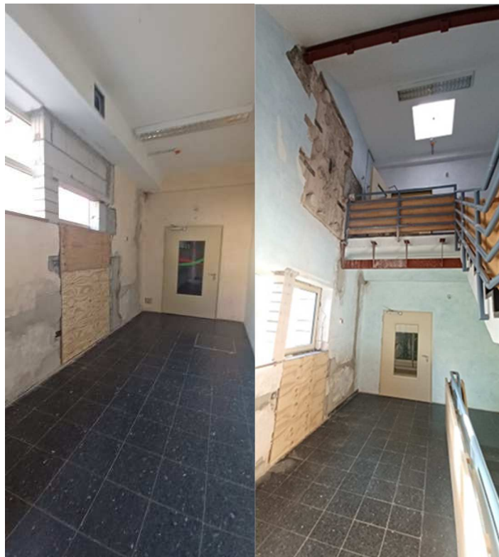
links: Blick ins Erdgeschoss; rechts: Blick in das 1. und 2. OG. Im 2. OG wird über Abhängung an den sichtbaren Stahlträgern das Podest zur Fahrstuhltür erweitert.
