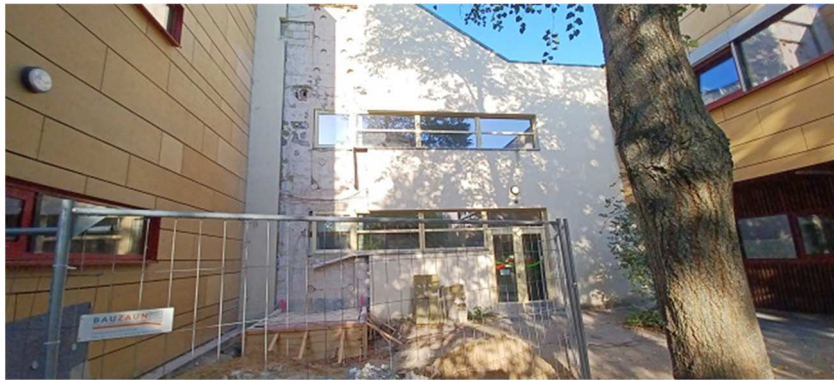
Hofansicht – hier sind die schon ausgesägten Fahrstuhlzugänge zu sehen
